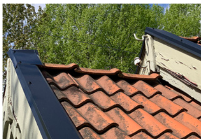
2. På taket på denna väntkur finns fästen för telefonledningar.
